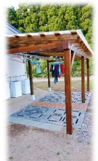
施工後 地面にパレットを埋め込む
